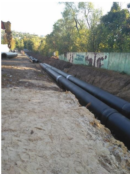
Фото 1-2. Заміна магістральних теплових мереж: 2-й Петренківський в'їзд і вул. Киргизька
