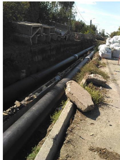
Фото 1-2. Заміна магістральних теплових мереж: 2-й Петренківський в'їзд і вул. Киргизька
