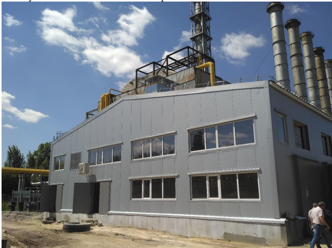
Фото 4. Будівництво когенераційної станції на котельні по вул. Артема Веделя, 4
