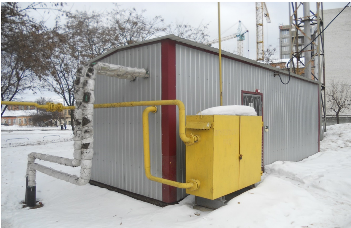
Фото 1 Блочно – модульна котельня (БМК).
