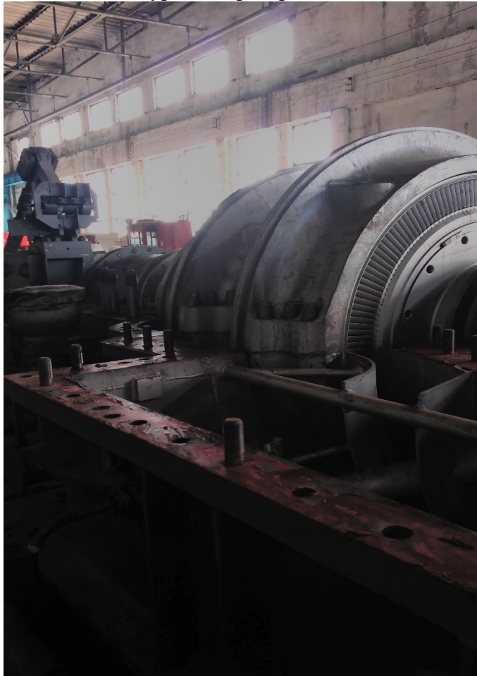
Фото 3. Турбогенератор №2 на ТЕЦ-3.
